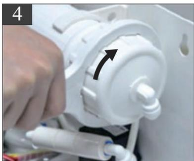
1. Retire el tubo del accesorio rápido y gire la tapa de la carcasa con una llave.
